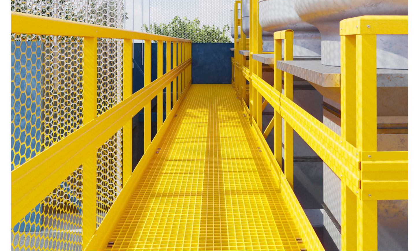
Pasarelas de tránsito
